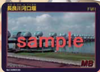
約1mの水位差を閘門で調整
